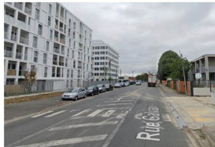
Bande cyclable provisoire à aménager Entre Léonard de Vinci et rue Migaux
